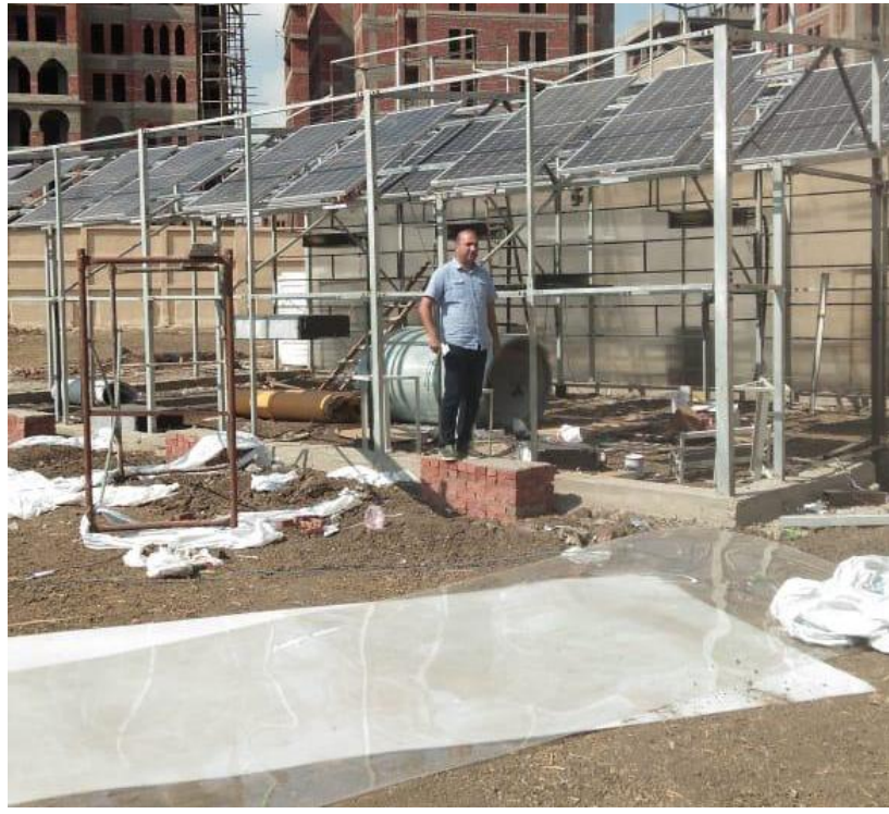
صورة رقم (3) الانتهاء من الهيكل المعدني وتركيب خلايا الطاقة الشمسية طبقا للتصميم العام في المقترح البحثي وبدء تغليف الصوبة ومجري التهوية (تغطية الخلايا الشمسية بالواح البولكربونيت الشفاف)
