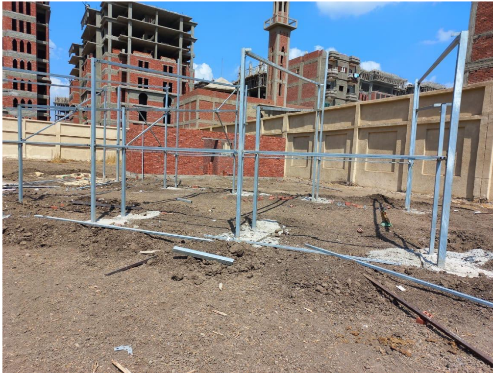
صورة رقم (2) بدء تنفيذ هيكل الصوبة وهي علي مساحة حوالي 100 متر مسطح (تحديدا 96 متر مسطح لاعمال الزراعة)
