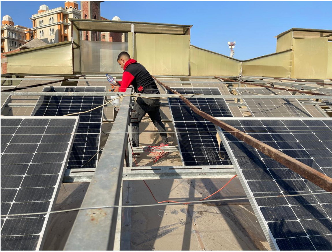
صورة رقم (16) ألواح الطاقة الشمسية بعد غسلها
